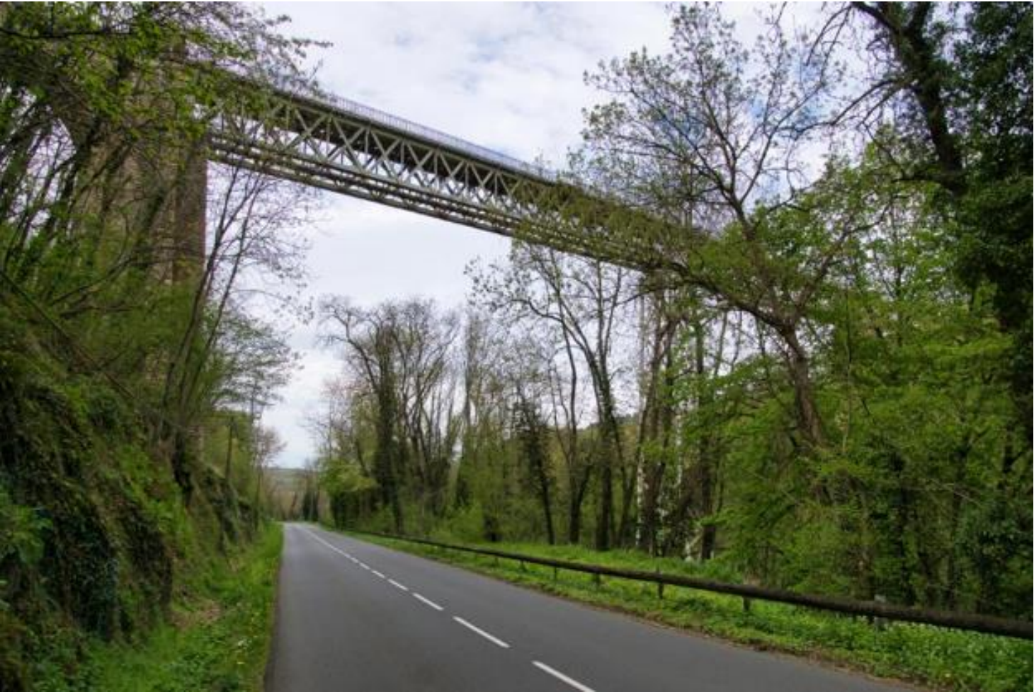
Viadotti di Rouzat e di Neuvial
