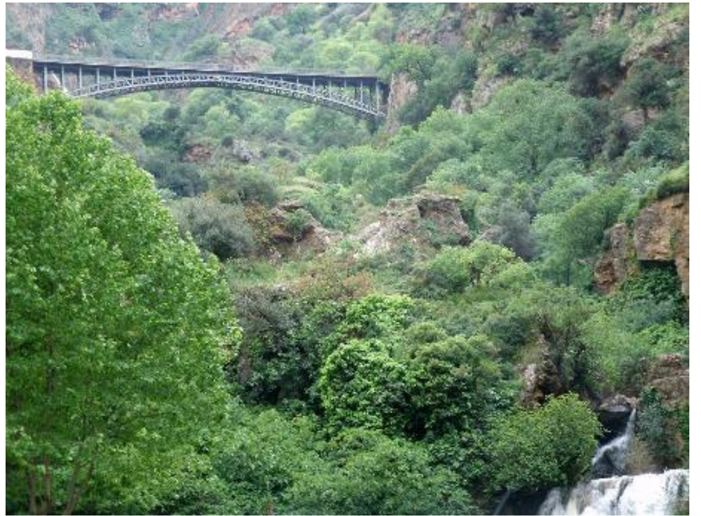
Ponti ferroviari delle Cascate di El- Ourit a Tlemcen (Algeria) e sul fiume Vecchio in Corsica.
