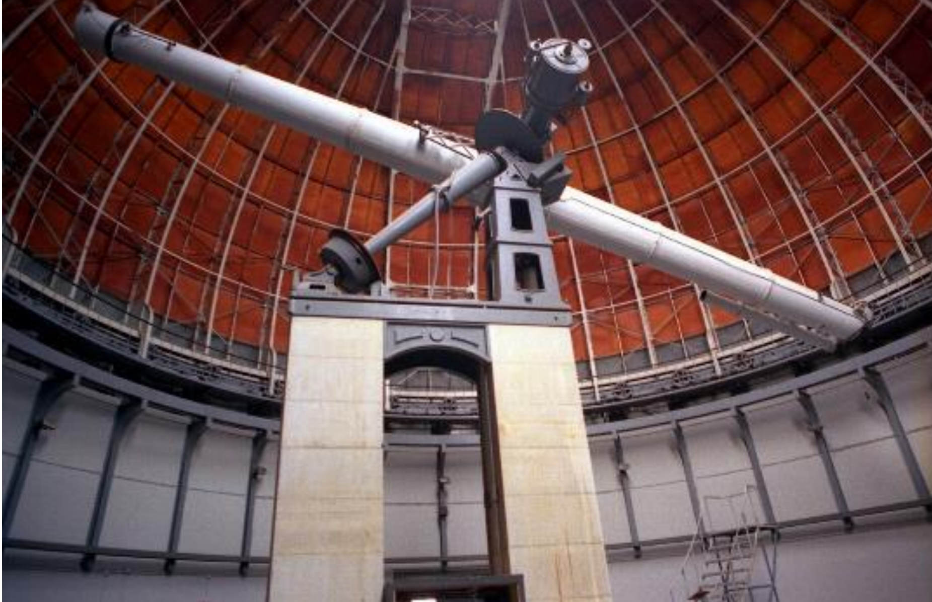
Osservatorio di Nizza, sulla vetta del monte Gros. Fondato nel 1879 dal banchiere Raphaël Bischoffsheim. Architetto Charles Garnier; Gustave Eiffel progettò la cupola principale.
