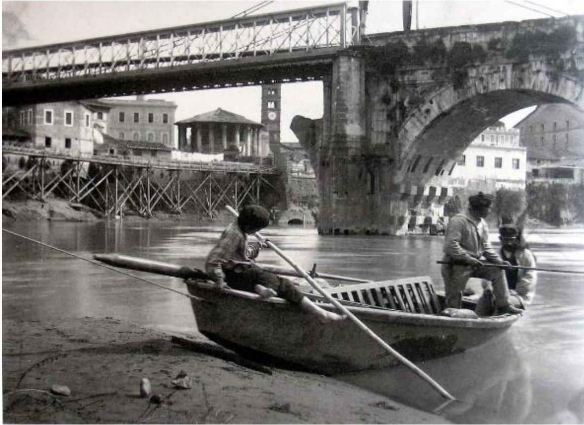
Roma. Ponte Emilio (Rotto) con la passerella in ferro. Foto Domenico Anderson, 1876
