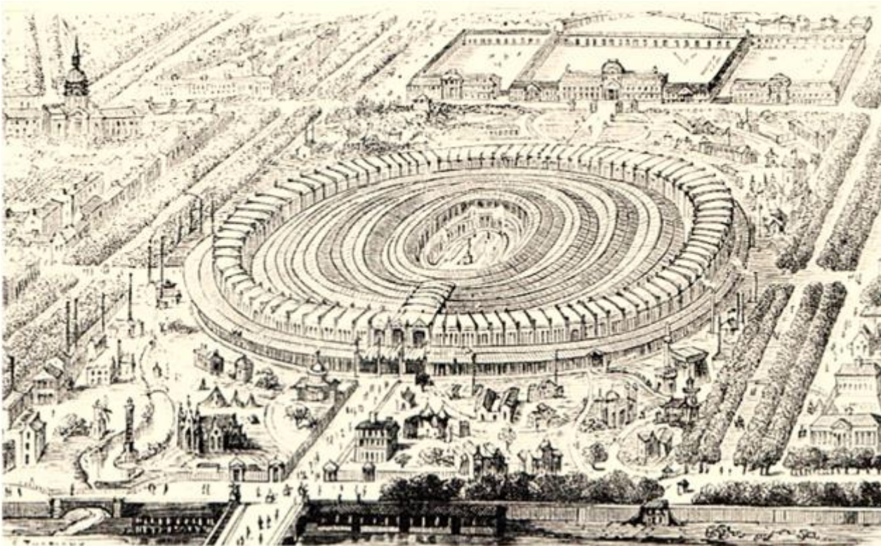
Parigi, Esposizione del 1867. Champ de Mars. Sette gallerie concentriche, la più esterna e vasta per le macchine, con ambulacro esterno
